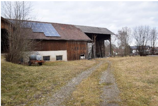
Abbildung 15: Haus Nr. 7 ehemaliger Kuhstall und Futter-silo
