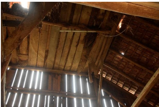
Abbildung 5: Haus Nr. 5, Innenansicht von Dach und Dachboden.
