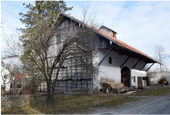
Abbildung 3: Hausnummer 5, Ansicht von Südost
