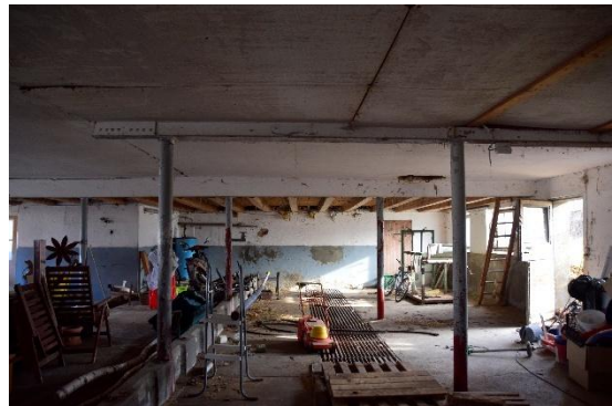
Abbildung 16: Haus Nr. 7 Kuhstall, Innenansicht
