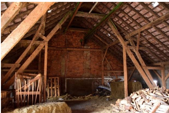
Abbildung 13: Haus Nr. 7 Innenansicht Dachboden mit Heulager
